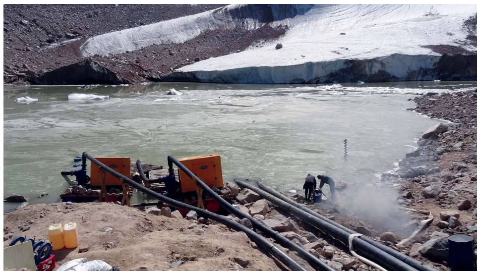
Откачка воды из приледникового озера № 13-бис насосами и сифонами
