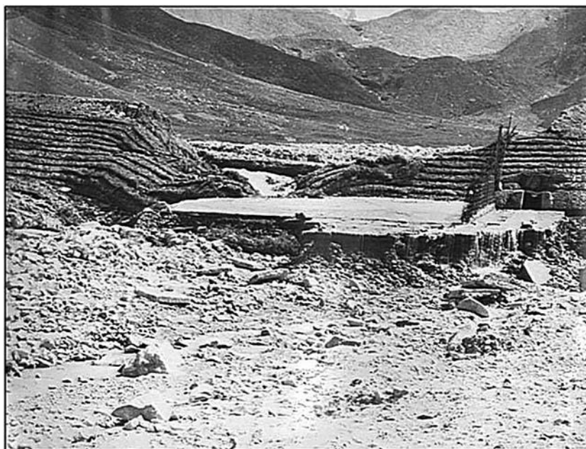
Рисунок 3.3 – Разрушение плотины в районе примыкания водослива к правобережной части, которое сопровождалось размывом нижнего бьефа
