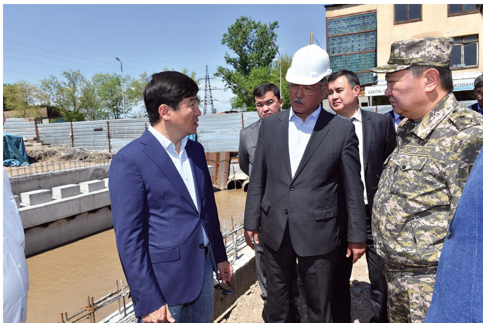
Аким г. Алматы Б. Байбек и начальник ДЧС г. Алматы С. Аубакиров инспектируют строительство селезачитных сооружений на реке Каргалы
