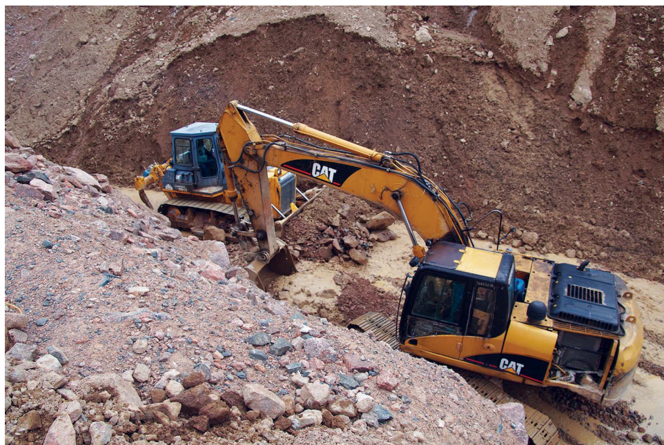
Прокладка эвакуационного канала для опорожнения приледникового озера № 6 с использованием экскаватора и бульдозера
