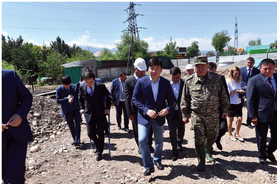
Аким г. Алматы Б. Байбек и начальник ДЧС г. Алматы С. Аубакиров осматривают селезачитные сооружения на реке Каргалы
